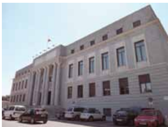
Fig. 5. Edificio Central del CSIC en Madrid. Fotografía de Luis García.
